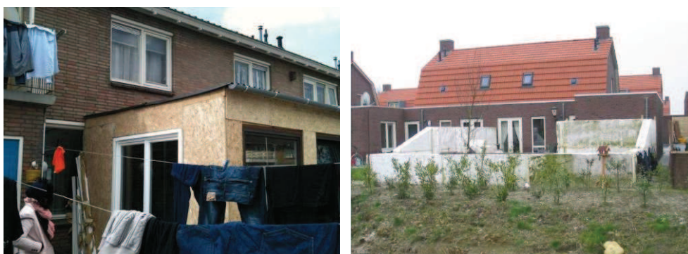
Afbeelding 11 - voorbeelden elders van ondeugdelijk/laagwaardig materiaalgebruik bij aanbouw (van plaatmateriaal dat niet voor buitentoepassing is bedoeld), resp. erfafscheiding (van bouwblokken voor binnenwanden) (bron: welstandsnota gemeente Oss, pag 13).
