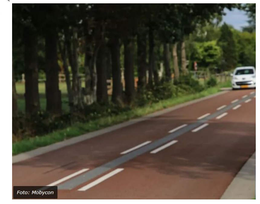
Groen parkeren Rode klinkers en een overrijdbare band in de middenstrook, auto te gast in de Burgemeester Van Oerslaan
