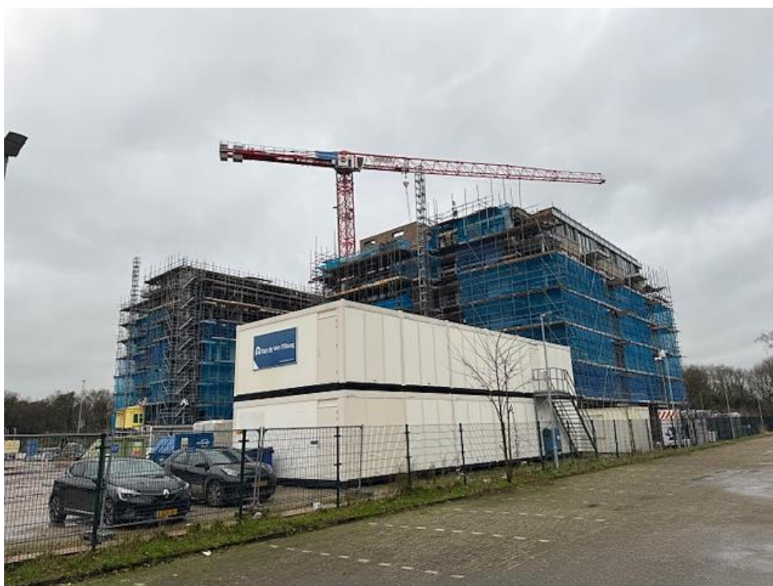
Appartementen in aanbouw
