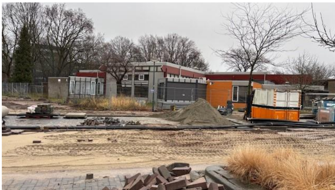
Foto bouwrijp werkzaamheden eind 2024
