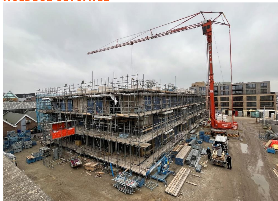
Bouwfoto januari 2025 Altera locatie
