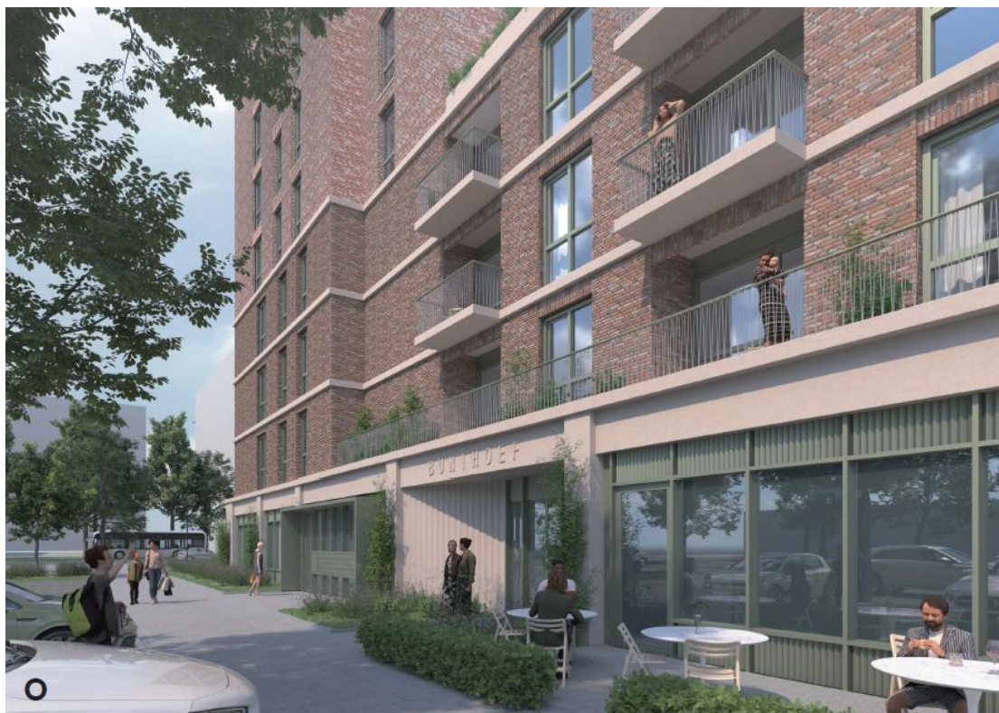
Het nieuwe activiteitscentrum in de plint van het gebouw (Bron: Oomen architecten)
