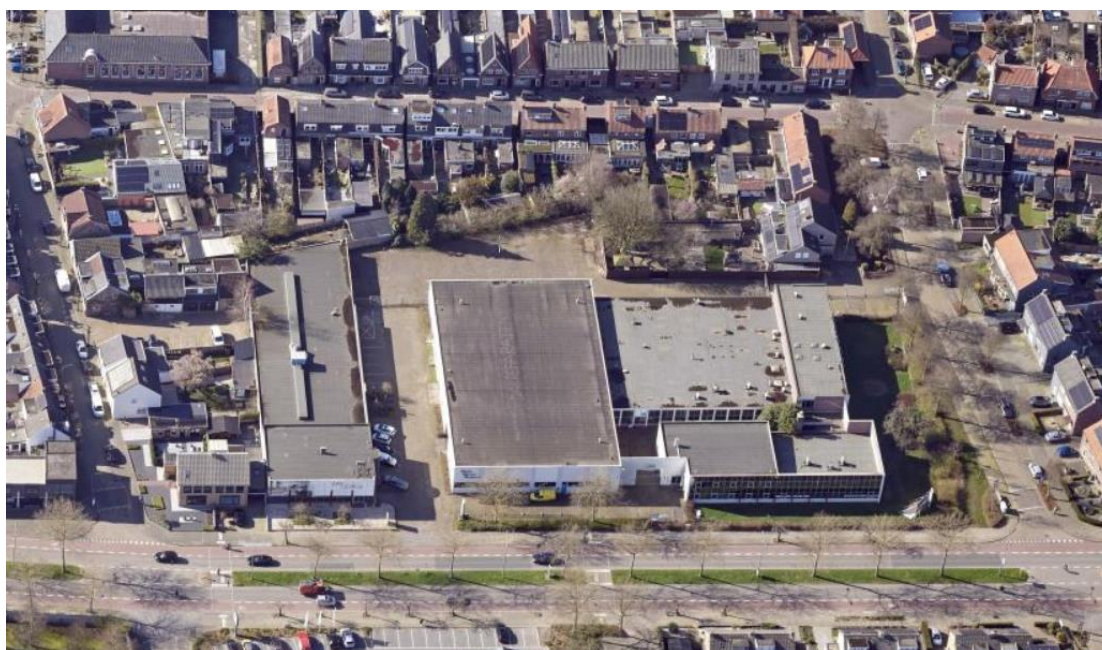
Luchtfoto plangebied aan de Abdis van Thornstraat
