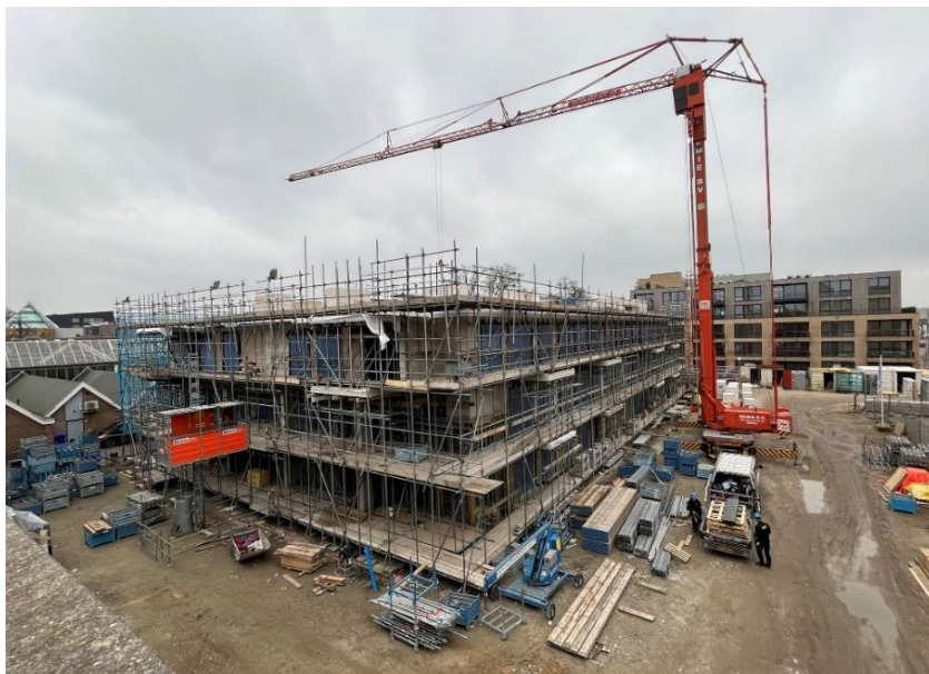
De bouw van het laatste appartementencomplex (Altera): foto januari 2025
