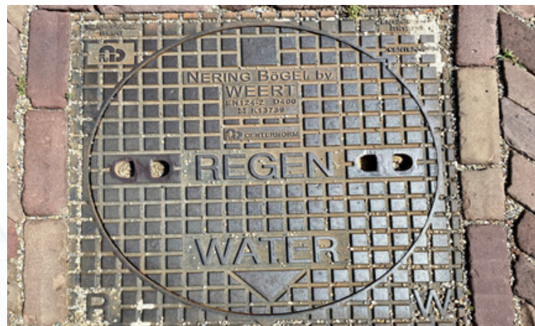
Putdeksel hemelwaterriool (Bronvermelding: RHDHV)
