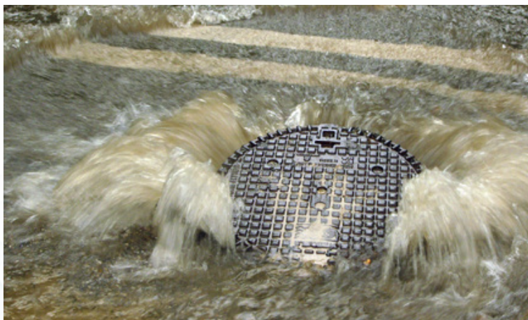
Overbelasting van de het openbare riool (Bronvermelding: GAW | stichting RIONED)
