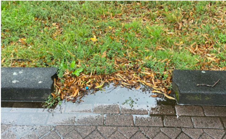
Infiltratiepunt (Bronvermelding: RHDHV)
