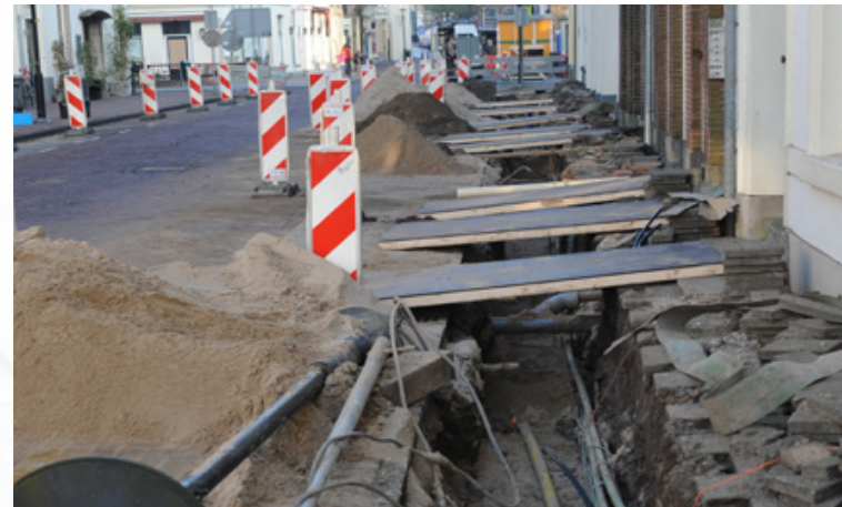
Kabels en leidingen in de grond (Bronvermelding: GAW | stichting RIONED)
