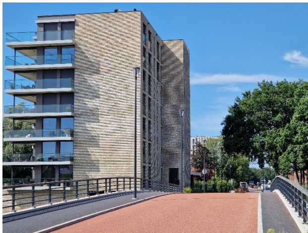
De geopende brug
