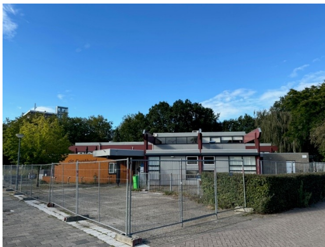
De werkzaamheden zijn gestart september 2024
